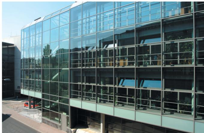
Bild 8: Die Doppelfassade dient als Klimapuffer und Schallschutz
