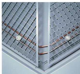
Bild 15: Die Kühldeckenverteiler und Sammelleitungen sind Bestandteil der Raumkühlfläche
