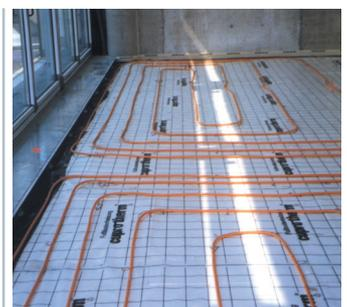
Bild 16: Fußbodensystem Cuprotherm® auch für die Kühlung ausgelegt
