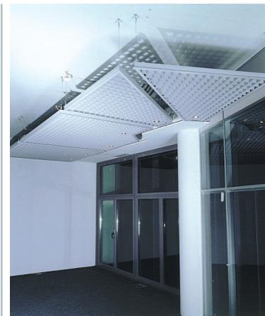
Bild 10: Rasterkühldecke entlang der Fassade
