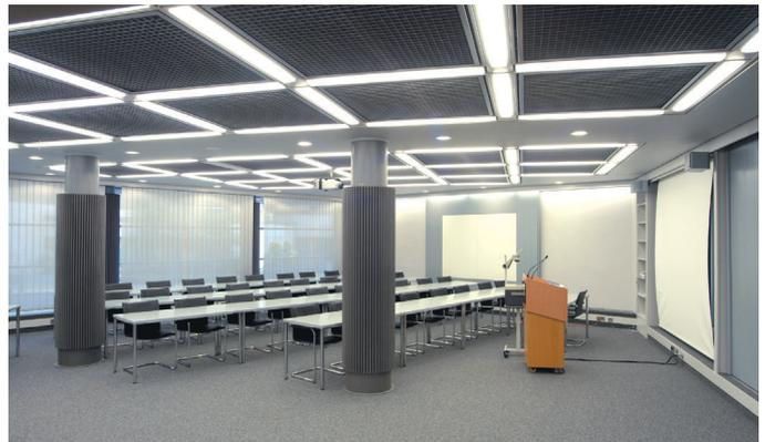
Bild 14: Hermann-Heusch-Saal im Bestand, Raumkonditionierung über Rasterkühldecken, Säulenheizkörper und Gebläsekonvektoren
